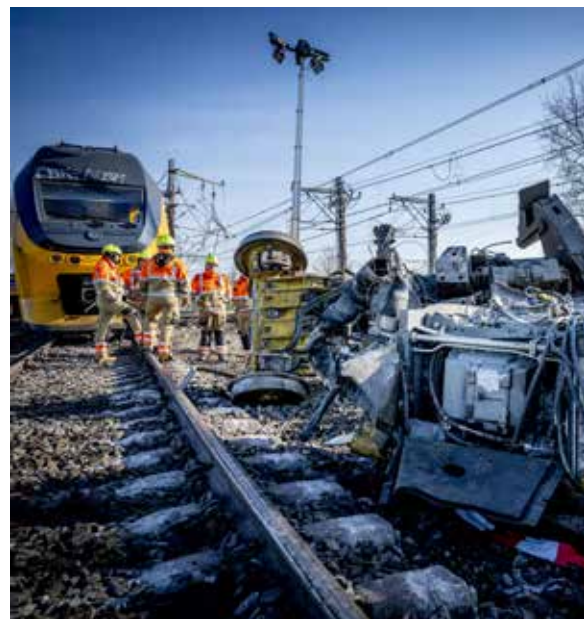
ProRail-medewerkers doen onderzoek bij de trein en de bovenleiding.
